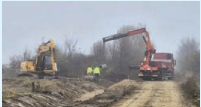
Započeli su radovi na izgradnji nove prometnice
